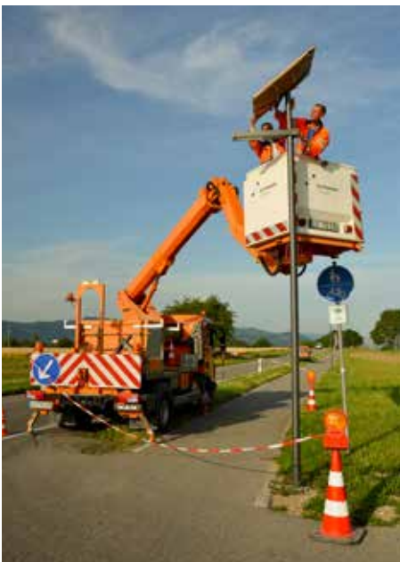
Installation der Solarleuchten am Radweg zwischen Hertzen und dem Markhof
